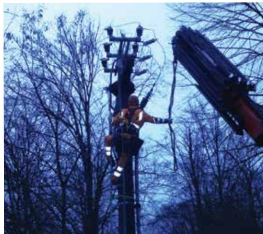
Vor Start der Bauarbeiten zum SBB-Projekt «Mehrspur Zürich–Winterthur» (u. a. Brüttener Tunnel) musste die letzte Mittelspannungsfreileitung über den SBB-Gleisen und der Töss in Winterthur zurückgebaut werden.
