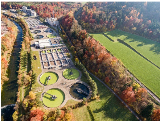
Luftbild ARA in Winterthur (Quellenangabe: Stadtwerk Winterthur, Patrick Walde)
