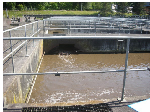
ARA: Biologische Reinigungsstufe (Quellenangabe: Stadtwerk Winterthur)
